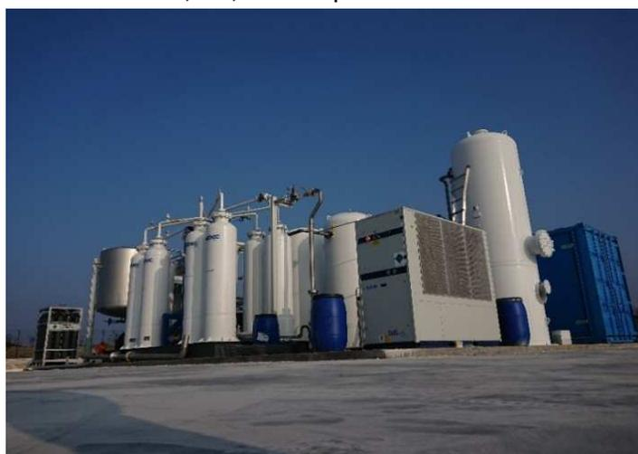
Figura 8: sezione di upgrading.
